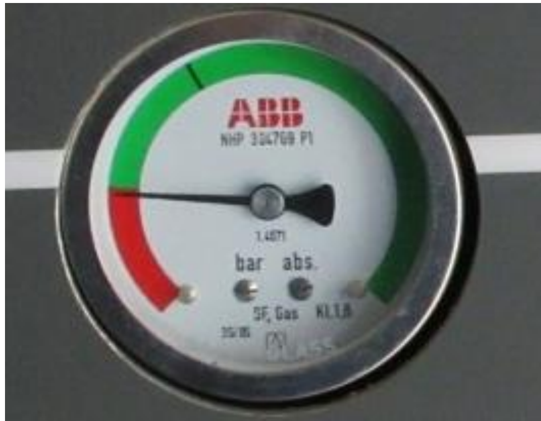
ABB SafeRing/SafePlus manomeeter. Temperatuurikorrigeeritud.
