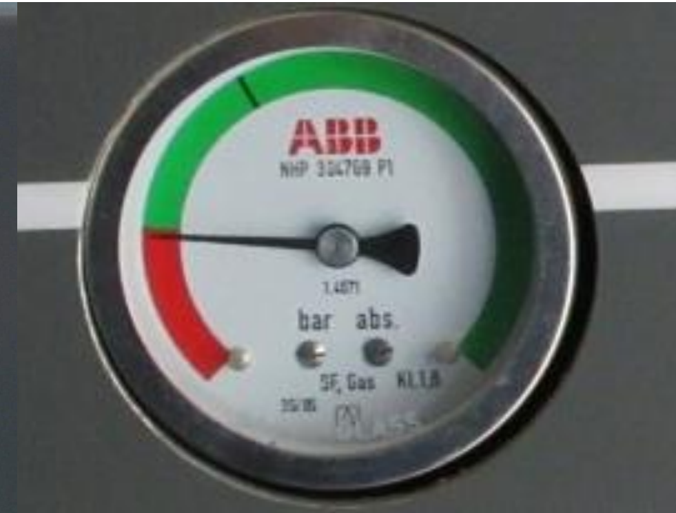
ABB SafeRing/SafePlus manomeeter. Temperatuurikorrigeeritud. See lahendus ei muutunud!
