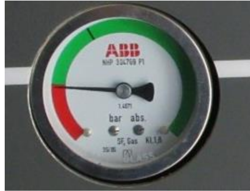
ABB SafeRing/SafePlus manomeeter. Temperatuurikorrigeeritud.
